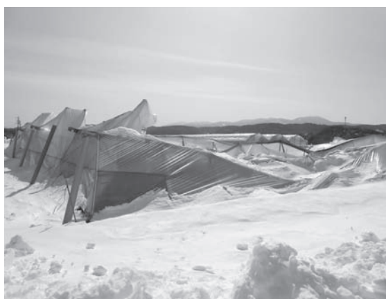
倒壊したパイプハウス
