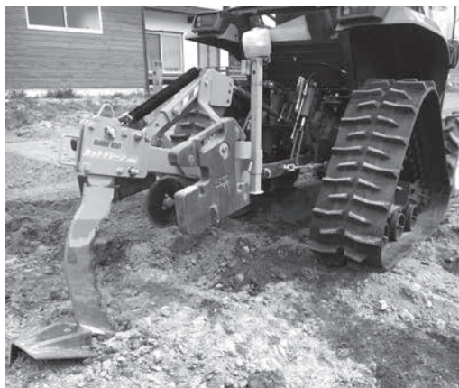
カットドレーンによる排水対策
