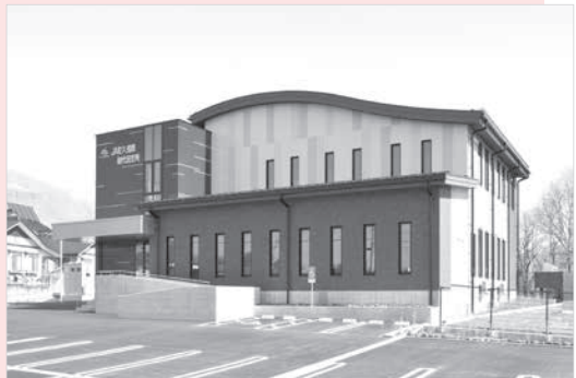
JA佐久浅間 御代田支所建設工事
