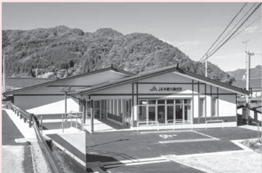
JA木曾 大桑支所建設工事
