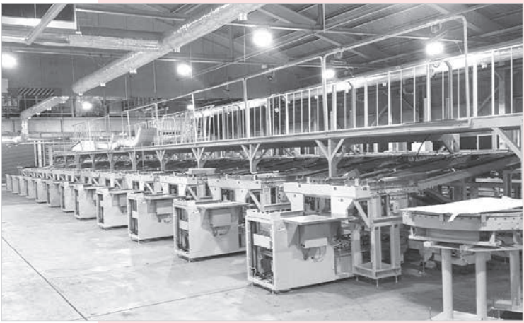
JA松本ハイランド 果実共選所選果設備他整備工事(施工状況)
