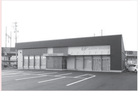
JAながの 安茂里支所建設工事
