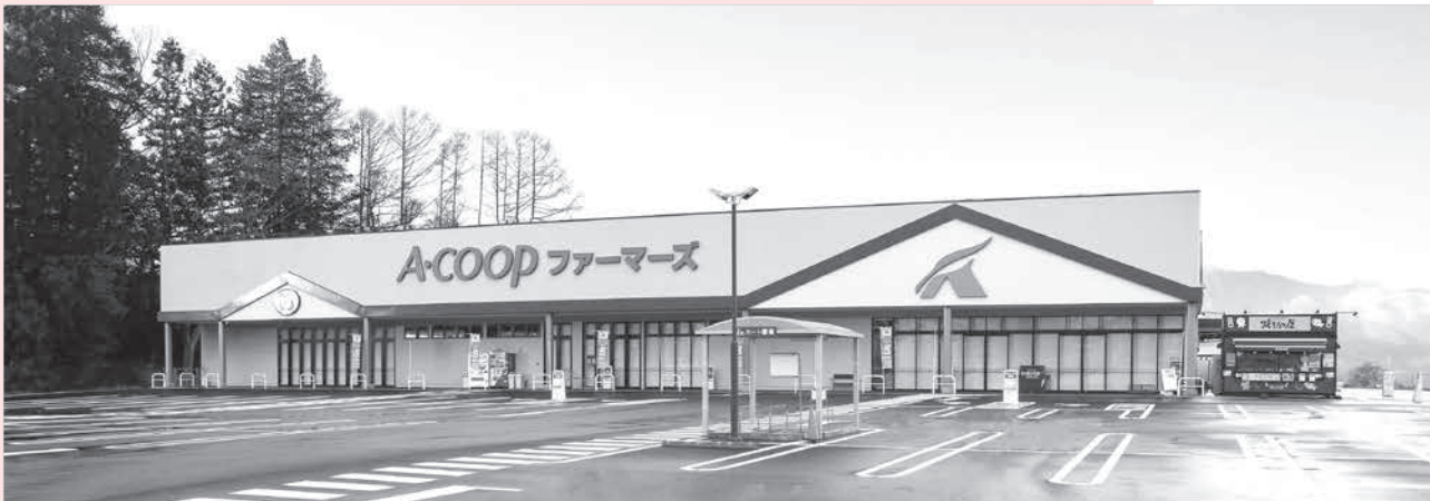
JA信州諏訪 A・コープファーマーズ サンライフ店建設工事
