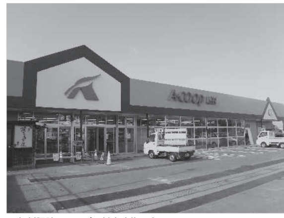
JA信州諏訪 A・コープ原村店改修工事
