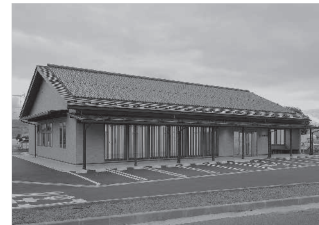
JAながの 小布施支所施設整備工事 外観
