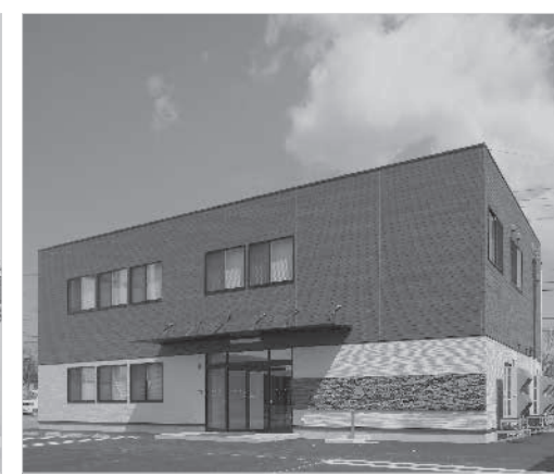
JA長野ハケ岳 野辺山営農センター建設工事
