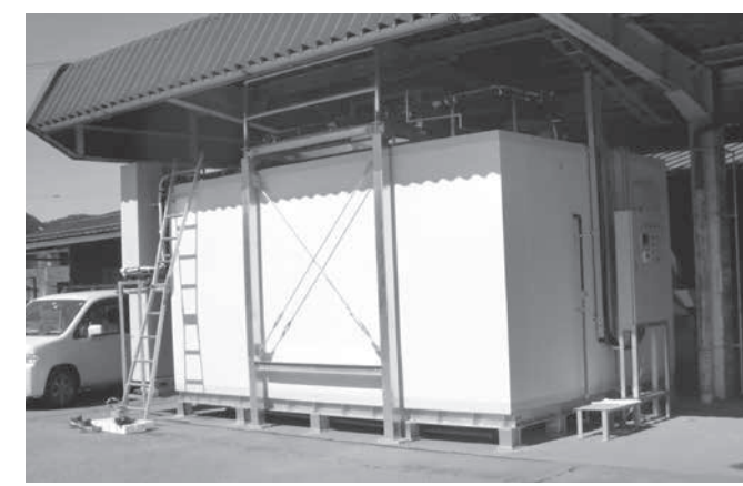
JA松本ハイランド 朝日集出荷場製氷機設置工事
