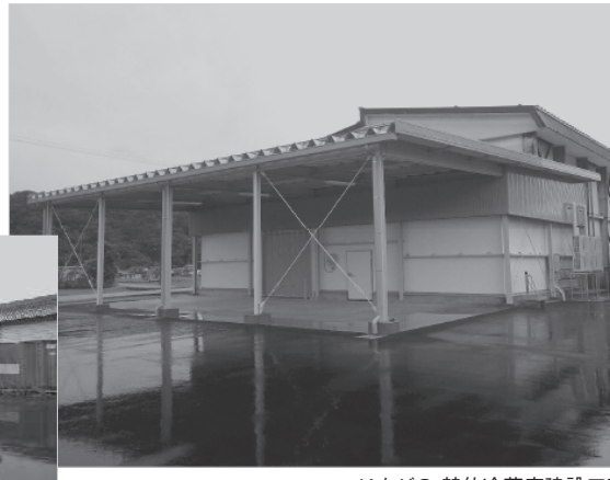
JAながの 替佐冷蔵庫建設工事
