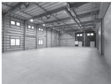
JA 洗馬 生活センター建設工事 内観
