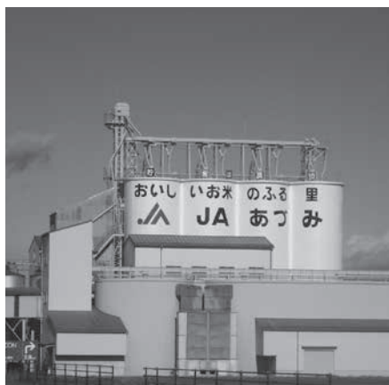
JA あづみ 鳥川ICEサイロ補修工事
