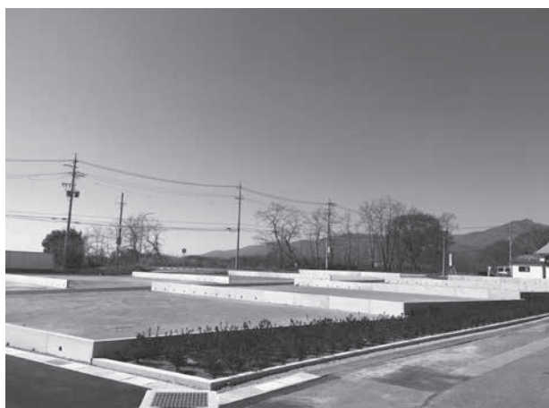
JA 佐久浅間(株)アメック 上平尾分譲宅地造成工事
