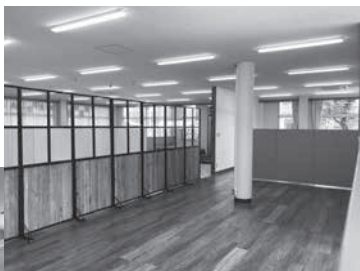
JA あづみ 南穂高支所事務所 改修工事
