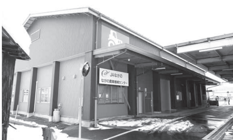
JA ながの 基幹農業機械センター施設整備工事 外観
