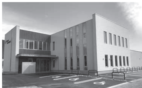
JA ながの ちくま増生支所施設整備工事 外観
