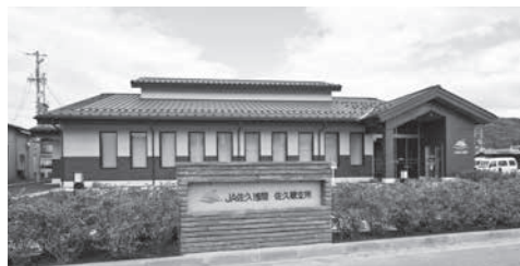
JA 佐久浅間 佐久穂支所建設工事 外観
