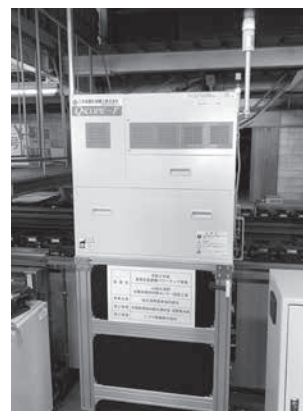
JA 佐久浅間 たてしなりんご共選所 内部センサー設置工事
