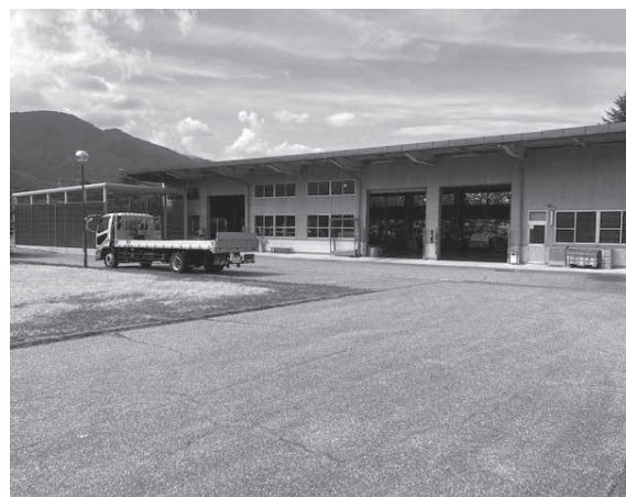
開所した整備センター外観
