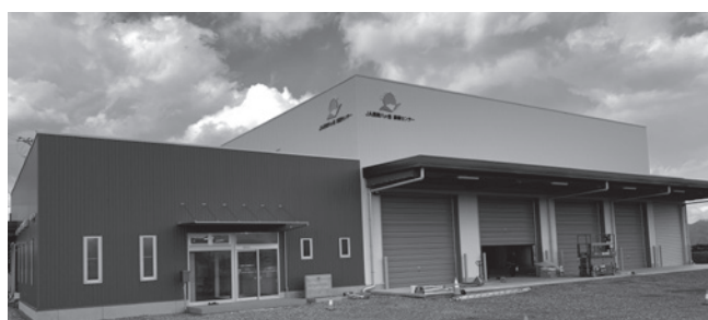
JA長野ハケ岳 農機センター建設工事
