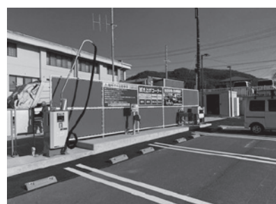
JA信州諏訪 玉川給油所駐車場土間工事
