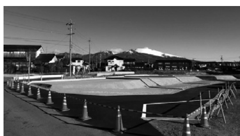
JA佐久浅間株式会社アメック 長土呂（十二）分譲宅地造成工事
