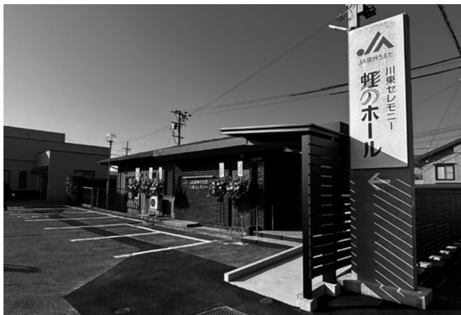
JA信州うへだ 旧古里店改修工事
