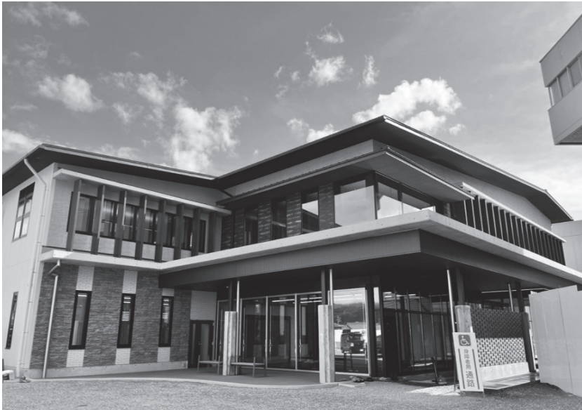
JAあづみ本所並びに豊科支所建設工事
