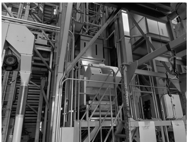
JA信州うへだ 泉田RC色彩選別機設置工事
