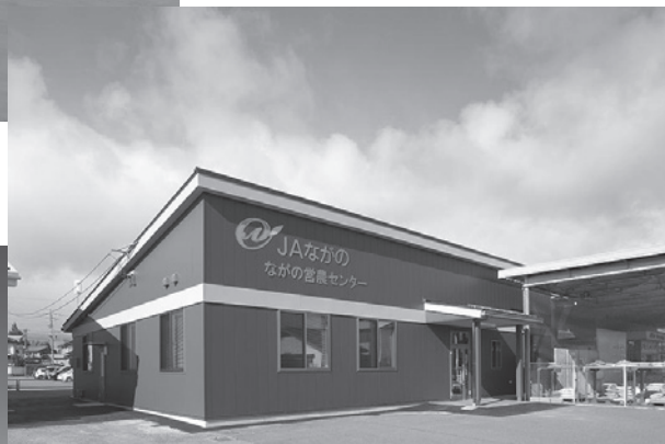
JAながの ながの営農センター建設工事
