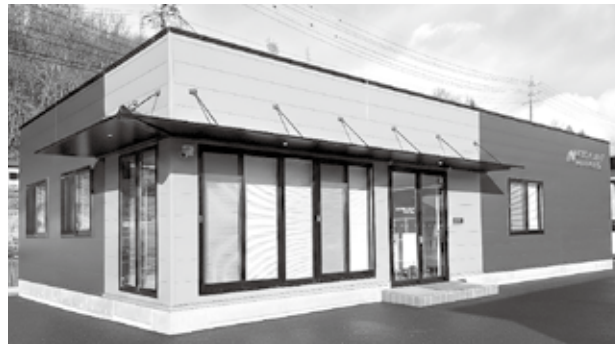
J A 松本ハイランド工機センター筑北事務所等移転新築建設工事（事務所棟）
