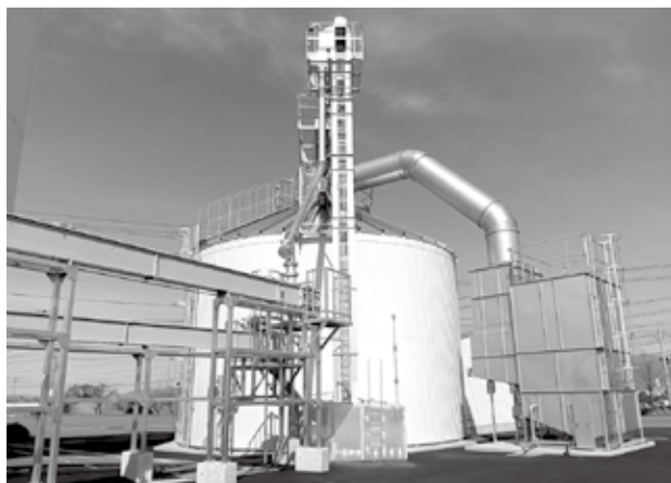
J A松本ハイランド広域和田ライスセンター工事
