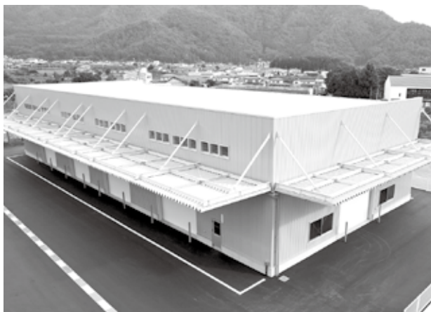
J Aながの須坂共選所建設工事
