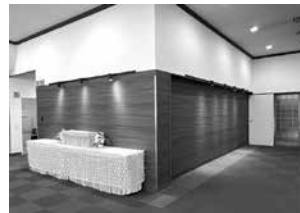
JA佐久浅間 サエーラあさま安置室改修工事
