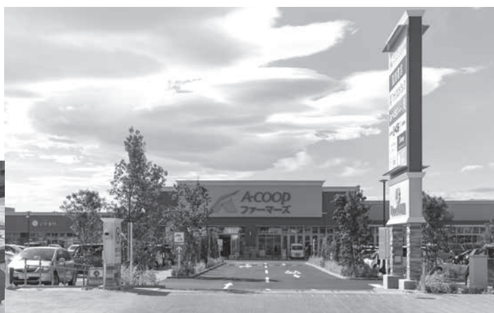
A・コープファーマーズ佐久平店建設工事
