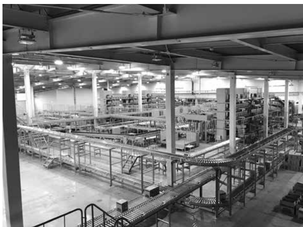
JA松本ハイランド すいか共選所選果機整備工事
