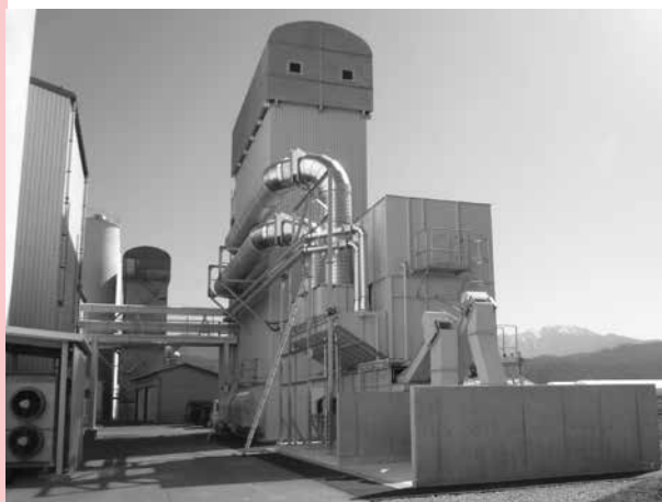
JA上伊那 美篤(4号) カントリーエレベーター増強工事
