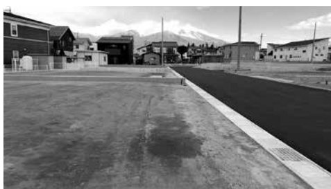
JA佐久浅間株式会社アメック 長土呂若宮分譲宅地造成工事
