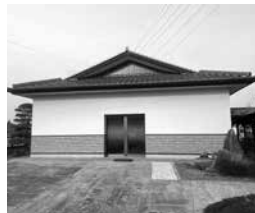
JAグリーン長野 JA 虹のホール稲里式場改修工事
